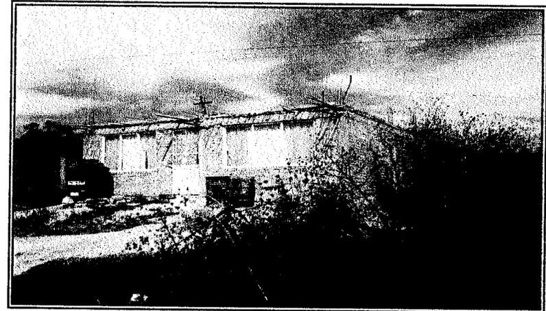
Fotografías de las viviendas, construidas con tabique, ventanas y puertas de herrería, techos de láminas de asbesto, láminas de metal, actualmente se encuentran habitadas, cuentan con energía eléctrica y almacenan agua en tambos rotoplax suministrada por pipas.
